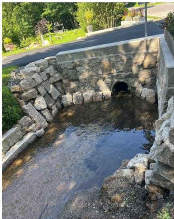
Oprava propustku po přívalových deštích v ulici Lukášovská
