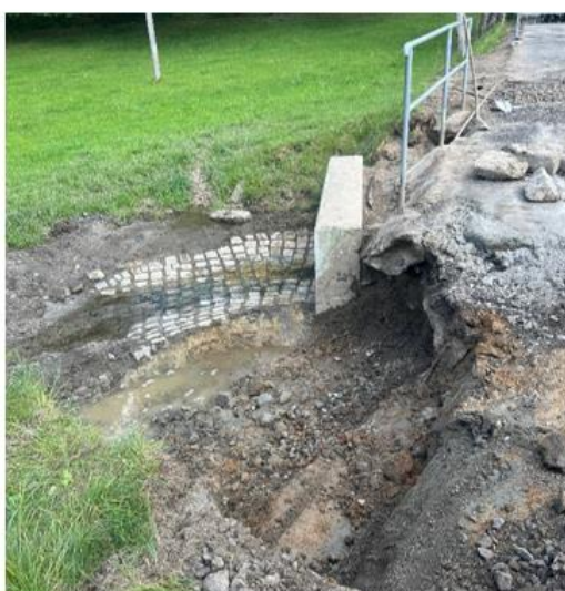
Oprava propustku po přívalových deštích v ulici Raspenavská
