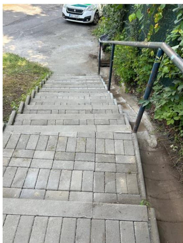
Oprava schodiště v ulici V Zahradách – předláždění zámkové dlažby
