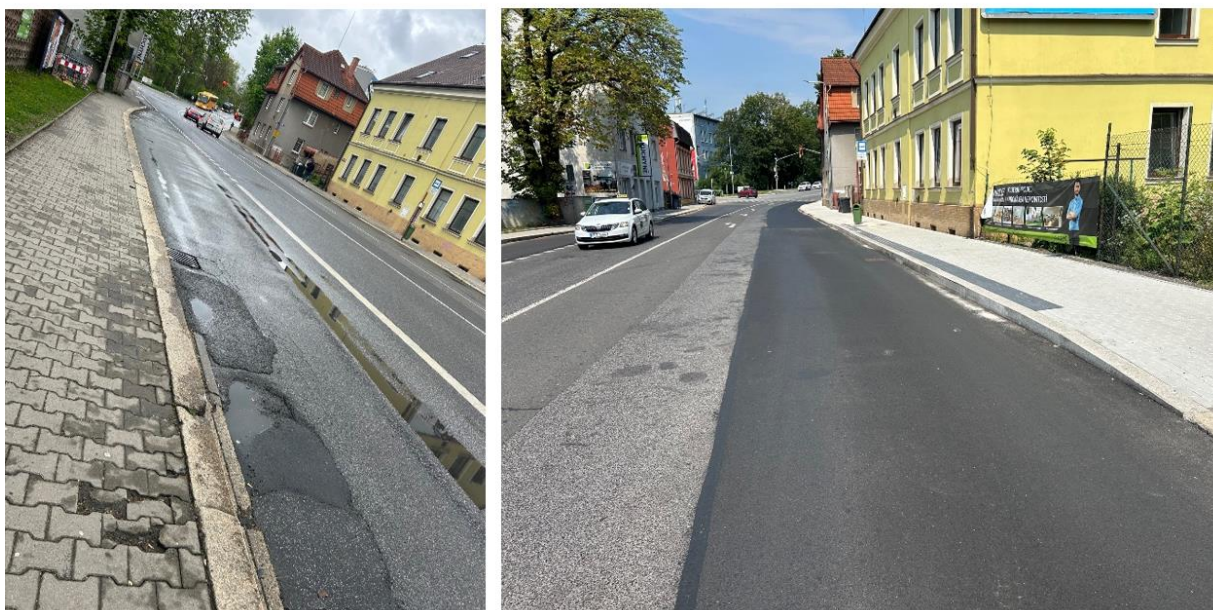
Oprava autobusové zastávky v ulici Horáková
