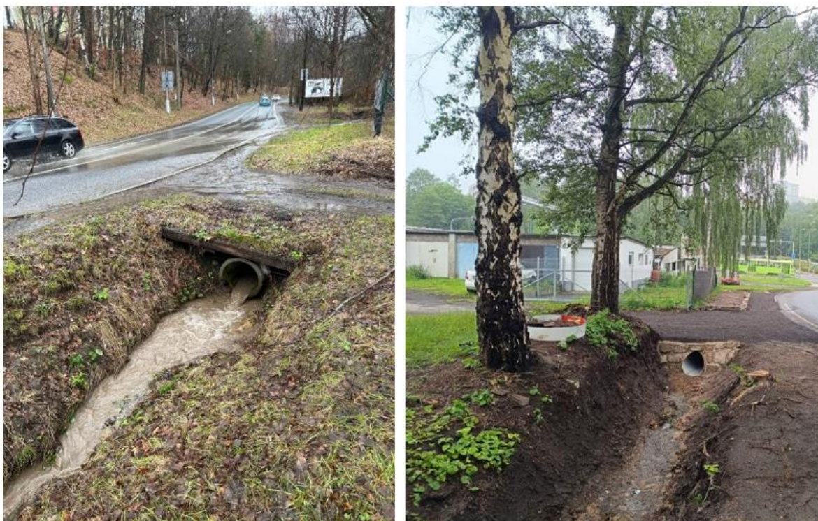
Oprava propustku v ulici Kunratická x Jablonecká – vyzdění nového čela z kamene
