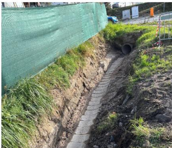
Oprava propustku po přívalových deštích v ulici Raspenavská
