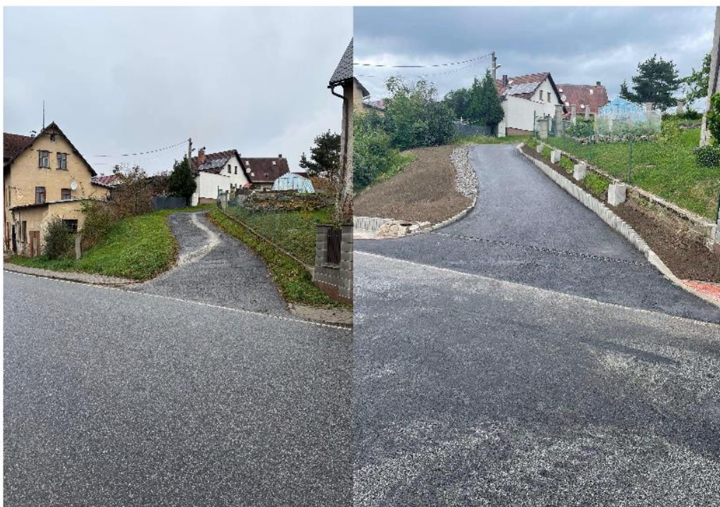
ul. Stará – úprava nevyhovujícího napojení na vozovku krajské správy
