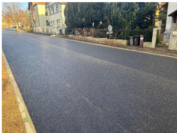
Štefánikovo náměstí – provizorní vozovka
