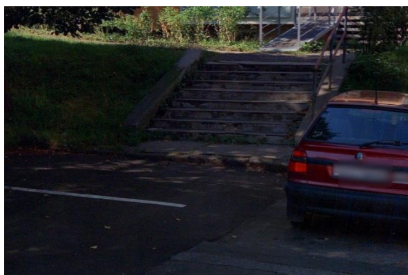
ul. Anglická – oprava schodiště
